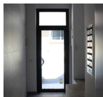
CAVA Puerta entrada al edificio con carpintería de aluminio de apertura hacia el interior, de serie alta, con rotura de puente térmico. lacado en color gris y con hueco vidriera.
